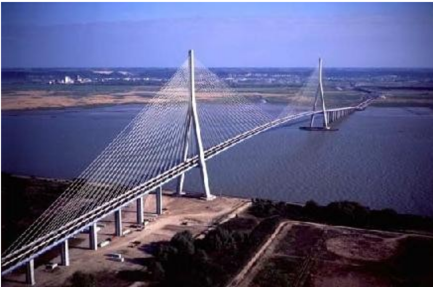
Pont gaulois à haubans du type "ueneto-briva"
